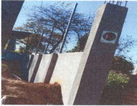
Foto 1: Vista lateral del muro de contención.
