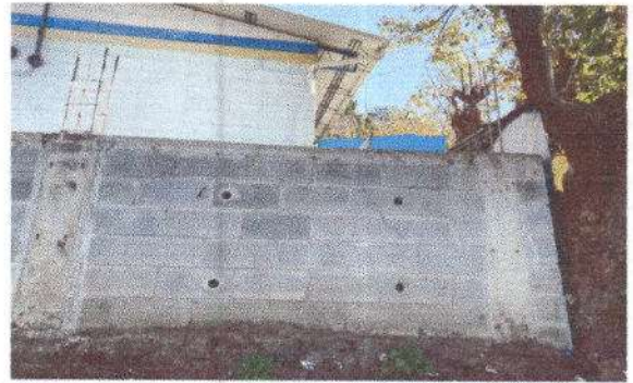
Foto 2: Vista externa del muro de contención.
