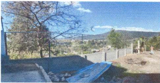
Foto 3: Vista interna del muro de contención.
